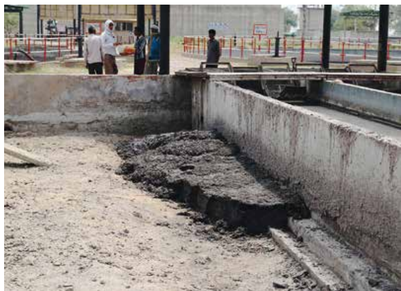
Klärschlamm aus Gerbereiabwässern
